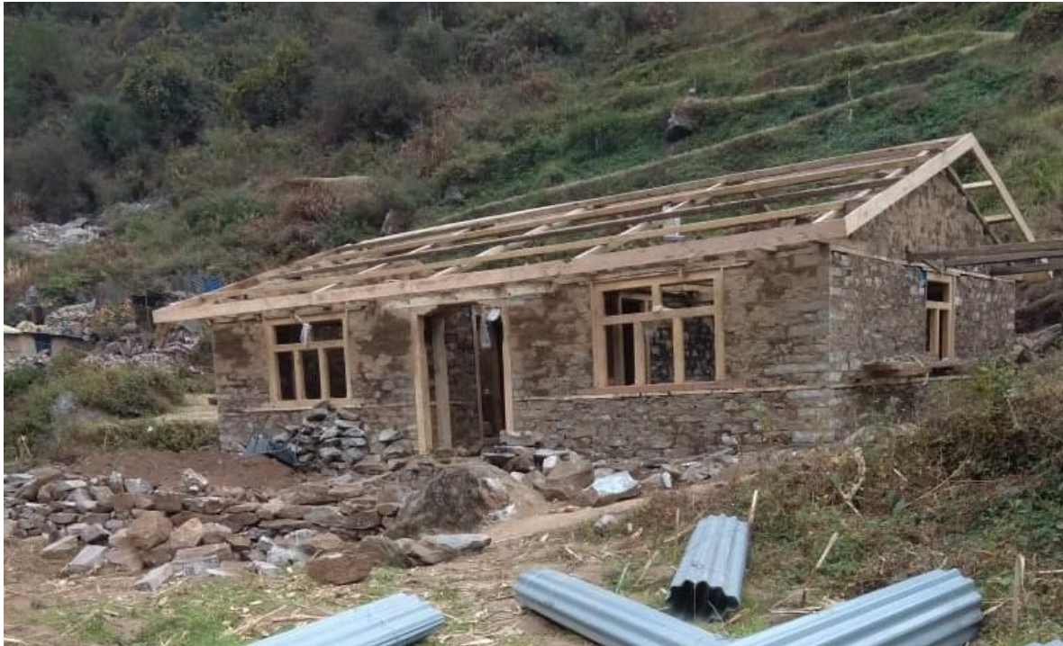
Abbildung 2: Das erste eingeschossige Haus kurz vor der Fertigstellung
