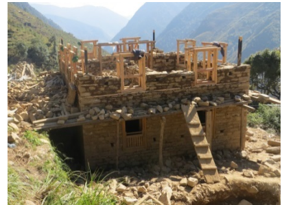
Abb. 3 : Arbeiten in Tempathang
