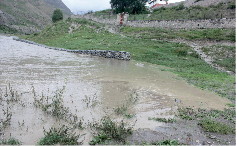
NEUE UFERVERBAUUNG SCHÜTZT DAS FLUSSNAHE GELÄNDE, IM HINTERGRUND DER NEUE ZAUN
